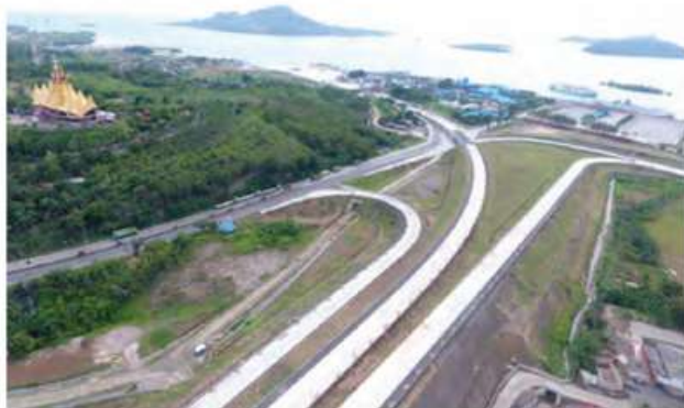
Bakauheni Sidomulyo – Lampung toll road project
