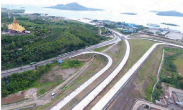
Bakauheni Sidomulyo – Lampung toll road project
