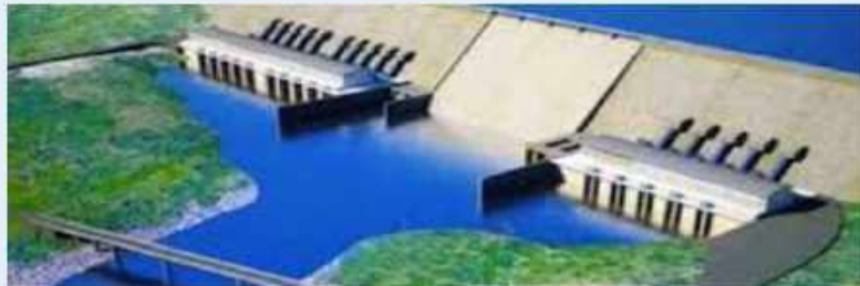
Way Apu Dam, Maluku
