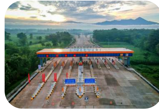
Tol Pandaan-Malang Nilai Kontrak: IDR 676M
