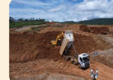
Jalan Hauling Ithaca IDR 1,4 T
