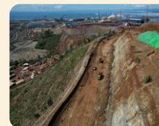
Pembangunan Tol Japek 2 Selatan IDR 130 M
