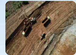
Jalan Akses Kediri Project IDR 1,1 T
