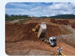
Jalan Hauling Itacha IDR 6,1 T
