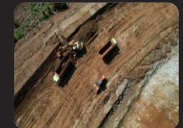
Jalan Akses Kediri IDR 1,1 T
