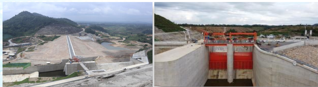
BENDUNGAN WAY SEKAMPUNG – LAMPUNG Way Sekampung Water Dam – Lampung
