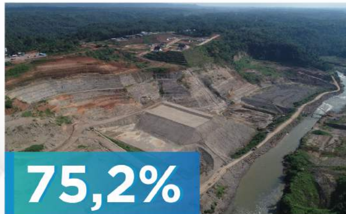
BENDUNGAN LEUWIKERIS TASIKMALAYA, JAWA BARAT Leuwikeris Water Dam Tasikmalaya, West Java
